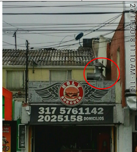
Fotografía No. 5. Ducto de desfogue.
